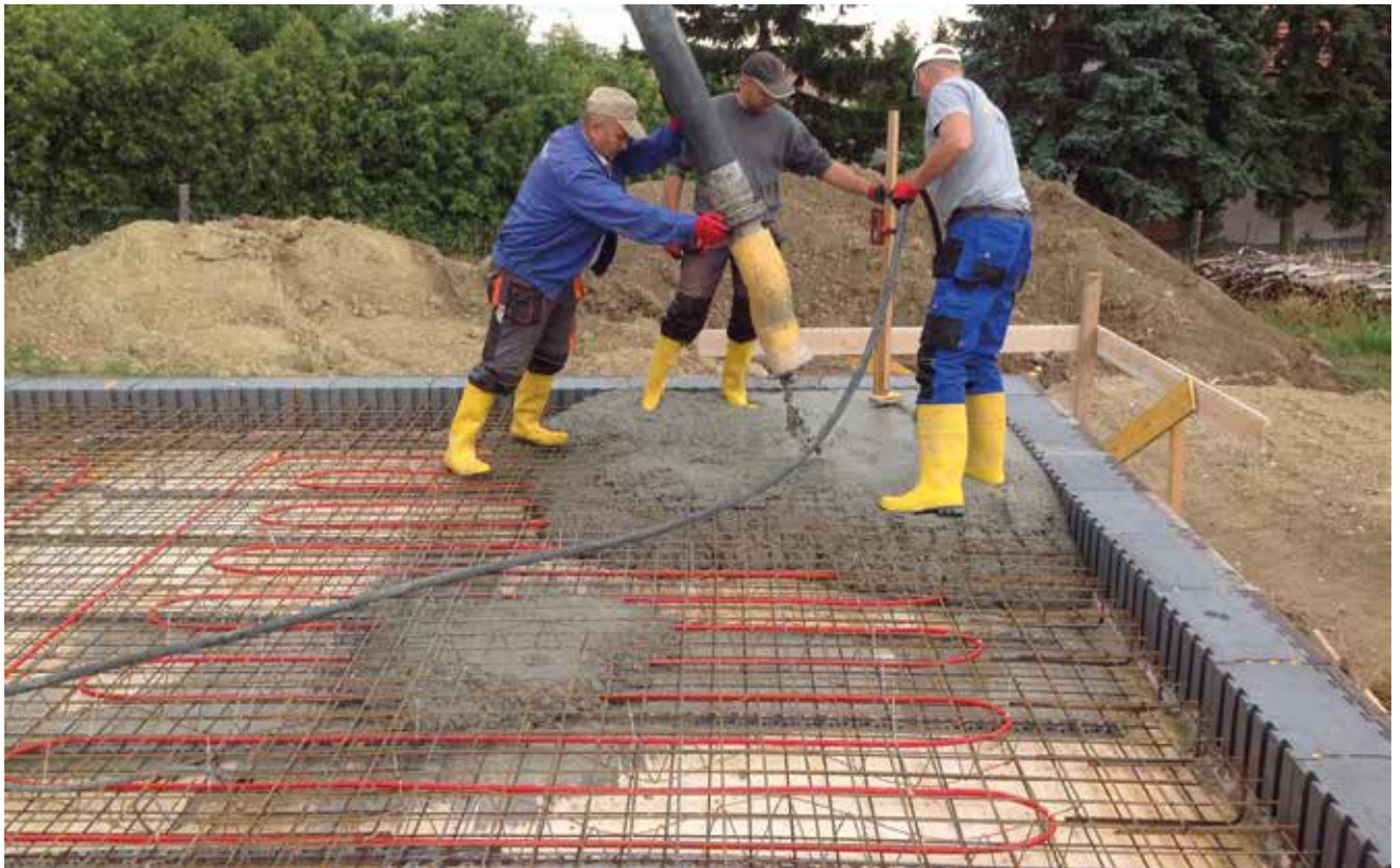
Abb. 1 | Bei der Bauteilaktivierung wird ein System von wasserführenden Rohrleitungen in Bauteile aus Beton verlegt. Das ist überzeugend einfach zu bewerkstelligen. © Aichinger Hoch- u. Tiefbau GmbH
