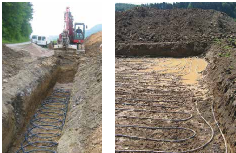
Abb. 37 | Ausführungsbeispiele von Erdkollektoren.
