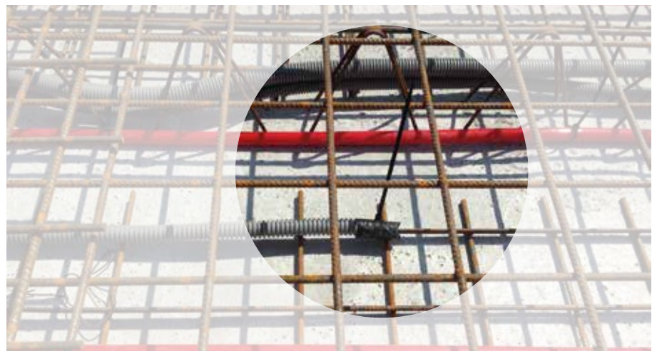
Abb. 26 | Einbau eines Temperaturfühlers im Bereich des Heizregisters, um die „Kerntemperatur“ zu messen. © Aichinger Hoch- u. Tiefbau GmbH
