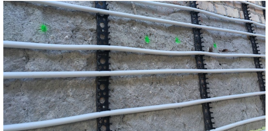
Aktivierung Bestandswand bei Sanierung; Quelle: Eigene Darstellung
