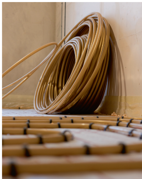
Kühlschlauch für Bauteilaktivierung.
