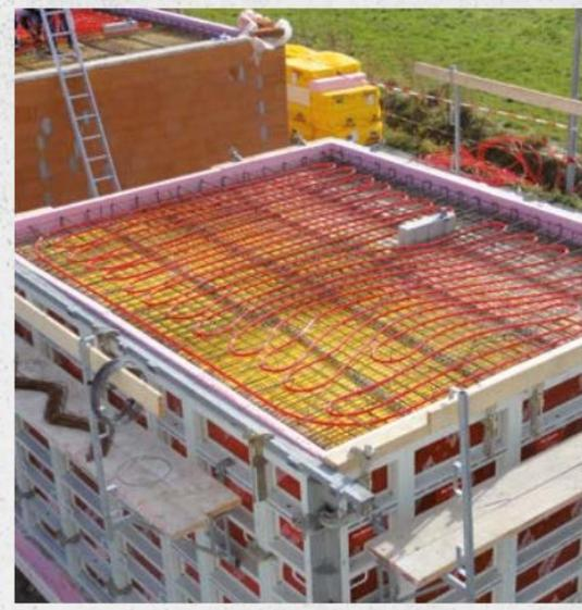
Abbildungen: Bauteilaktivierung der Wände und der Decke auf dem Versuchsgelände der Zukunftsagentur Bau Salzburg
