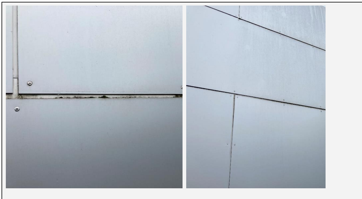
Abb. 3-6: Metallfassaden mit Verschmutzung 41
