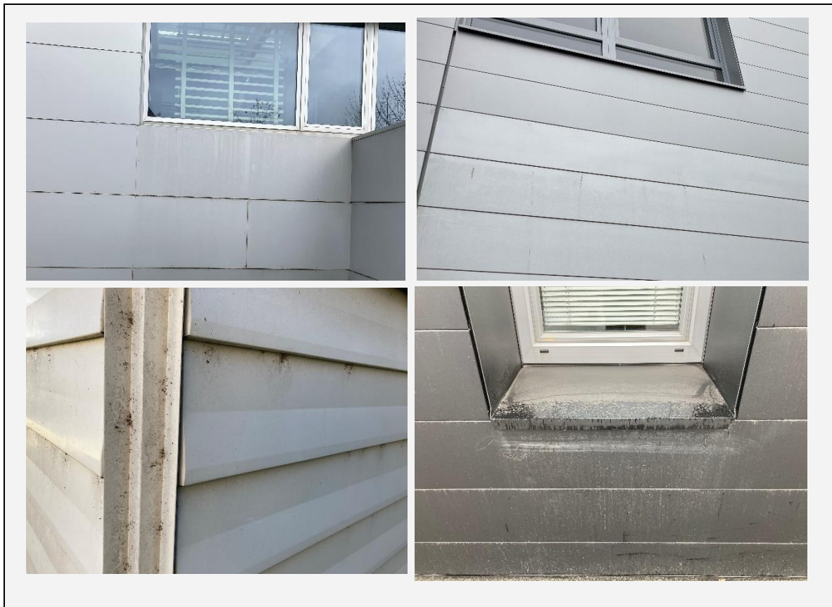
Abb. 3-7: Beispiele für Veränderungen der Metall-Oberfläche im Laufe der Nutzungszeit unterschiedlicher Metallfassaden 43
