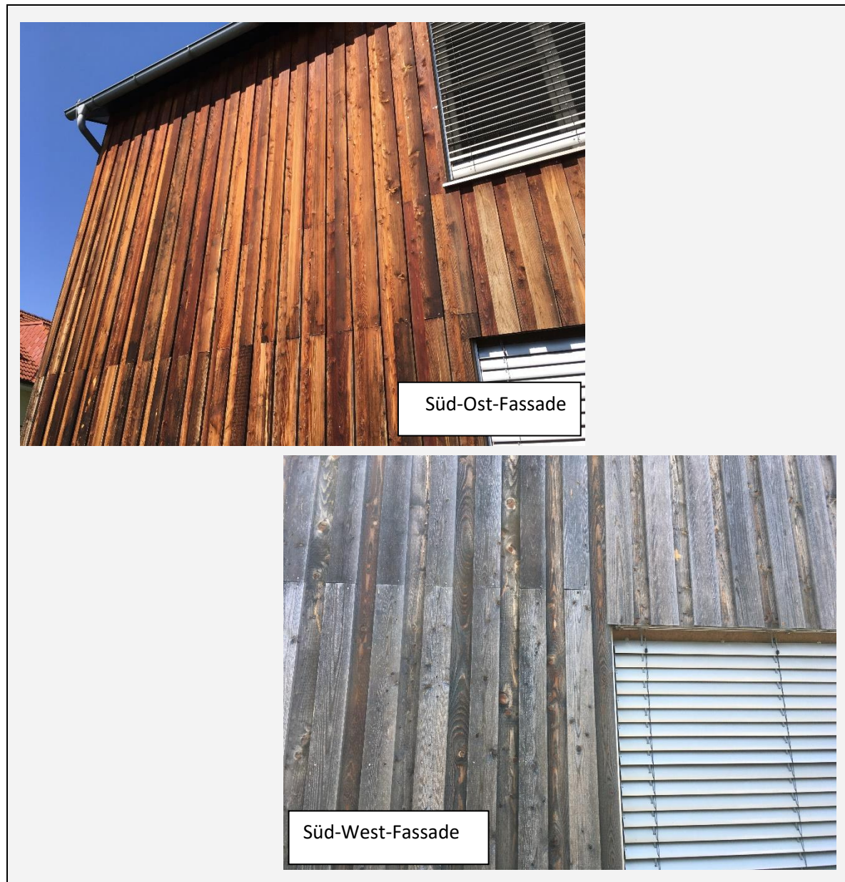
Abb. 3-4: Natürliche Abwitterung einer unbehandelten Holz-Fassade nach 9 Jahren Nutzungszeit 37
