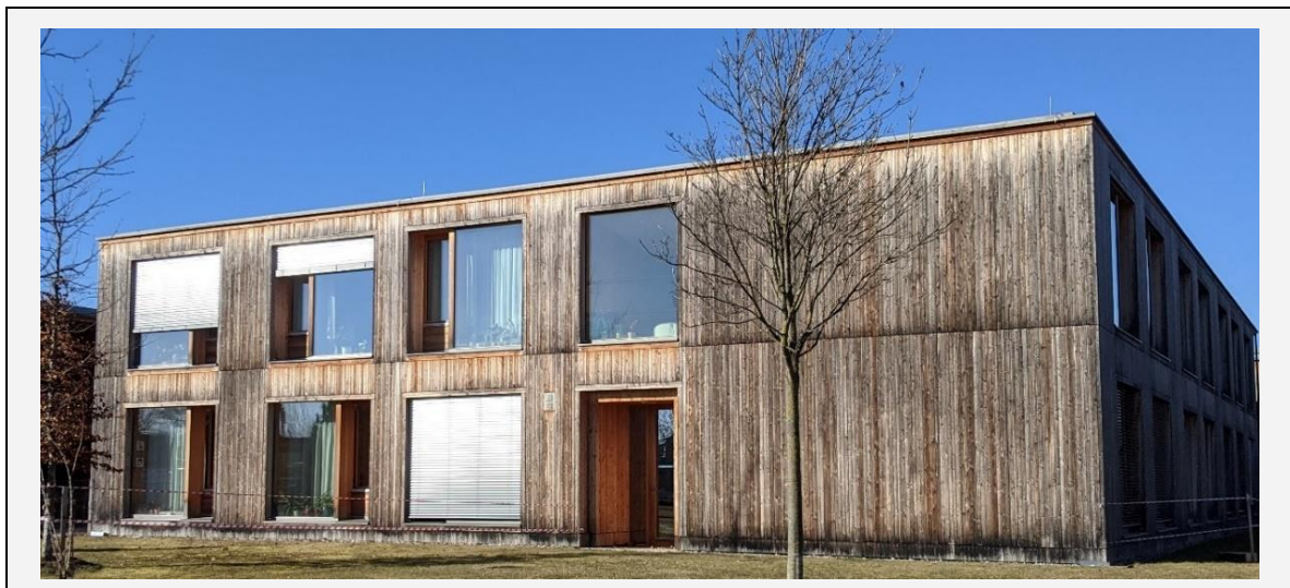
Abb. 3-3: Natürliche Abwitterung einer unbehandelten Holz-Fassade nach 8 Jahren Nutzungszeit 36
