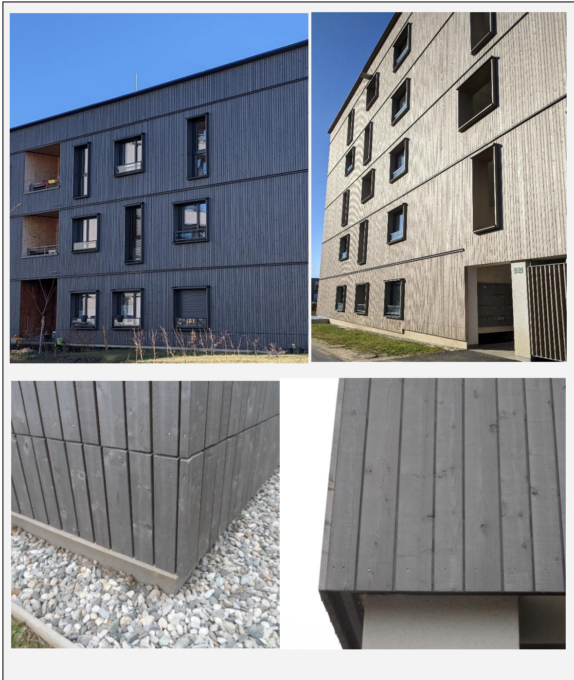
Abb. 3-5: Vorbehandelte Holz-Fassade mit Vergrauungslasur, Neuzustand 38
