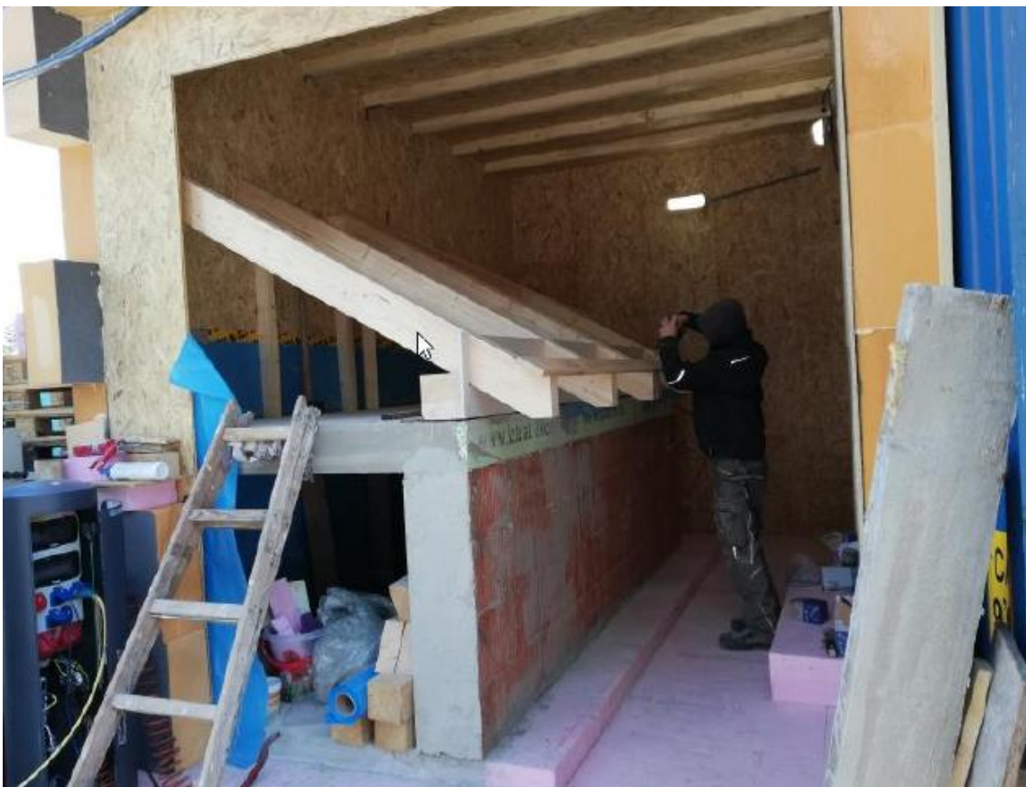
Abb. 3.5: Rohbau: Dachstuhl
