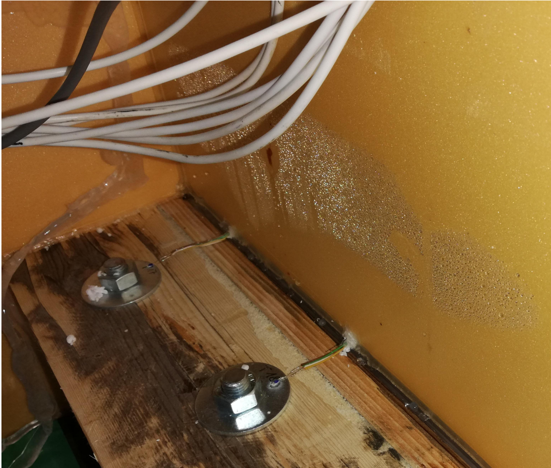
Abb. 3.7: Kondensat an der Aussendämmplatte bei Mauerbank auch bei hohem s_d -Wert. Ggf. Restfeuchte aus den wiederverwendeten EPS-Platten
