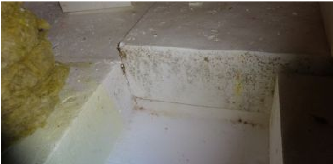
Abb. 1.2: Schimmel an EPS-Stößen
