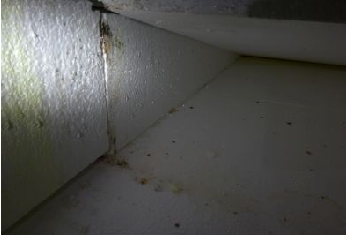
Abb. 1.3: Kondensat an EPS-Stößen
