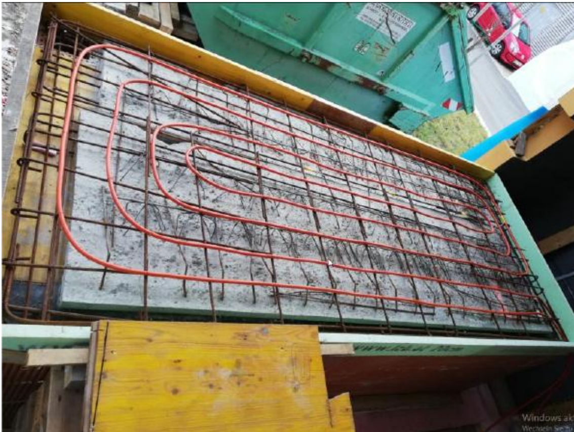
Abb. 3.2: Rohbau: Stahlbetondecke mit eingelegten Heizschlangen
