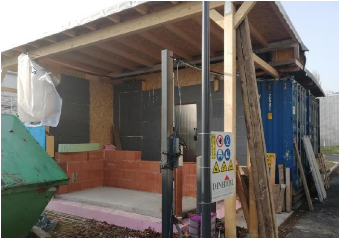
Abb. 3.1: Rohbau mit Ziegelaußenwand
