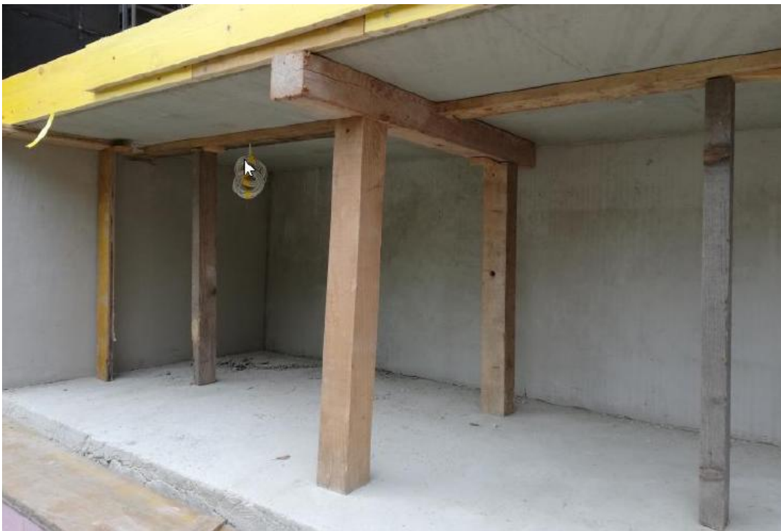
Abb. 3.3: Rohbau: Wohnraum unter Dachstuhl/Stahlbetondecke
