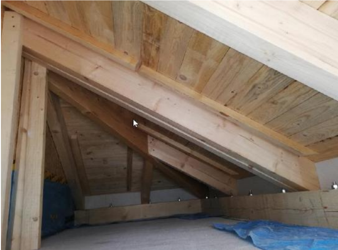
Abb. 3.4: Rohbau: Blick von innen in den Dachstuhlteil mit Gebäudeecke
