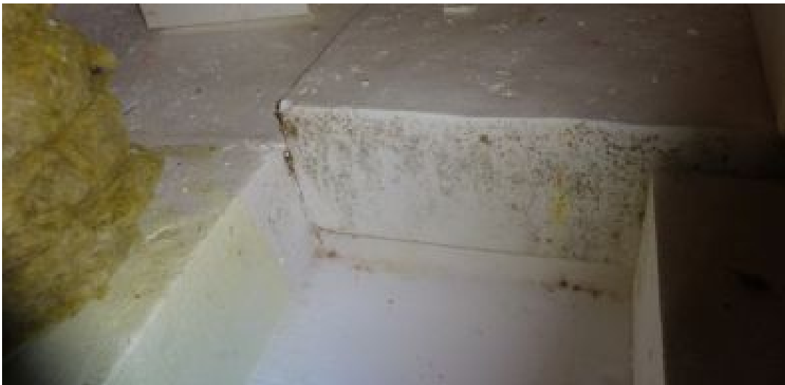
Abb. 1.2: Schimmel an EPS-Stößen
