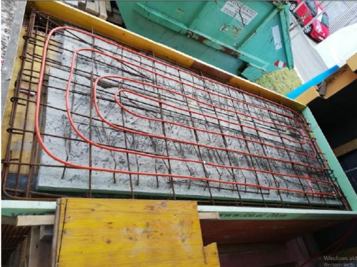
Abb. 3.2: Rohbau: Stahlbetondecke mit eingelegten Heizschlangen
