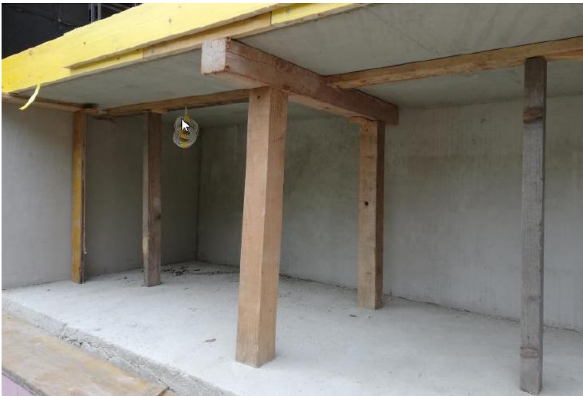
Abb. 3.3: Rohbau: Wohnraum unter Dachstuhl/Stahlbetondecke
