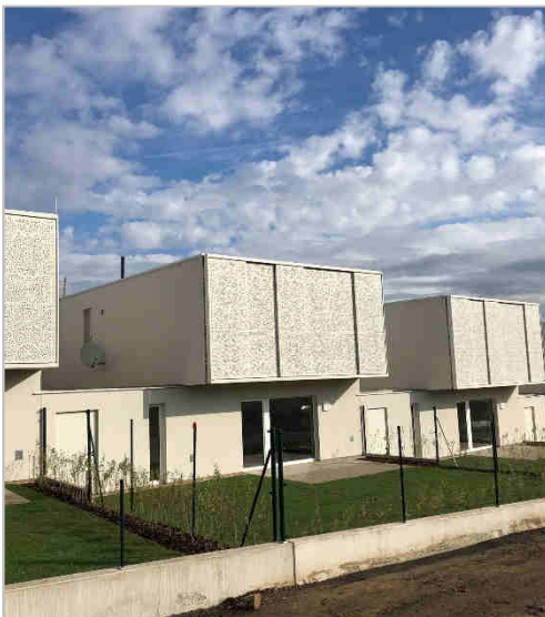
14 Reihenhäuser des 1. Bauabschnitts fertiggestellt. Foto © EBSG
