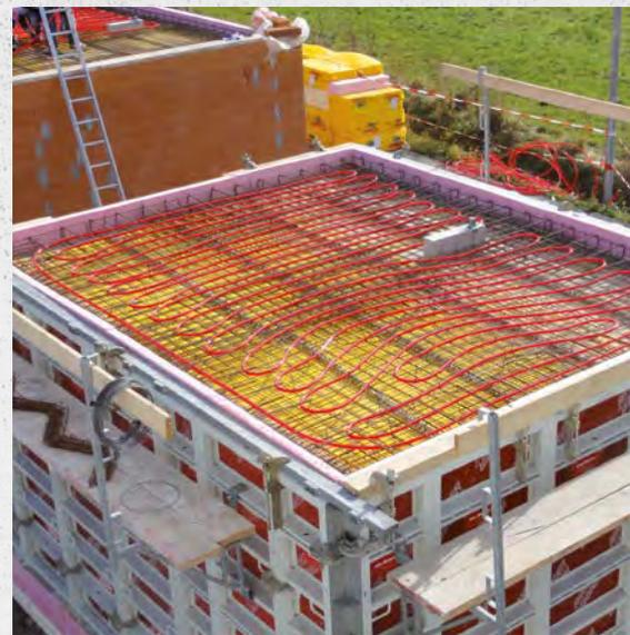
**Beton speichert von Natur aus Wärme und Kälte besonders gut. Diese Eigenschaft macht sich die thermische Bauteilaktivierung zunutze. Beton nimmt dabei die gewünschte Temperatur über in seinem Inneren verbaute Wasserrohrleitungen auf und gibt sie gleichmäßig und langanhaltend an seine Umgebung ab. Wie effizient das in der Realität verläuft, wurde mit Hilfe eines Simulationsraums getestet.**
