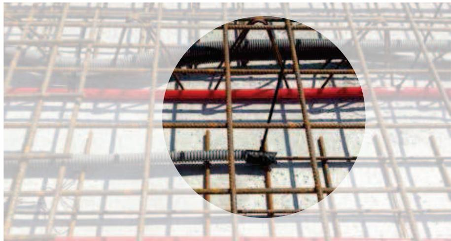
**Abb. 26** | Einbau eines Temperaturfühlers im Bereich des Heizregisters, um die „Kerntemperatur“ zu messen. © Aichinger Hoch- u. Tiefbau GmbH
