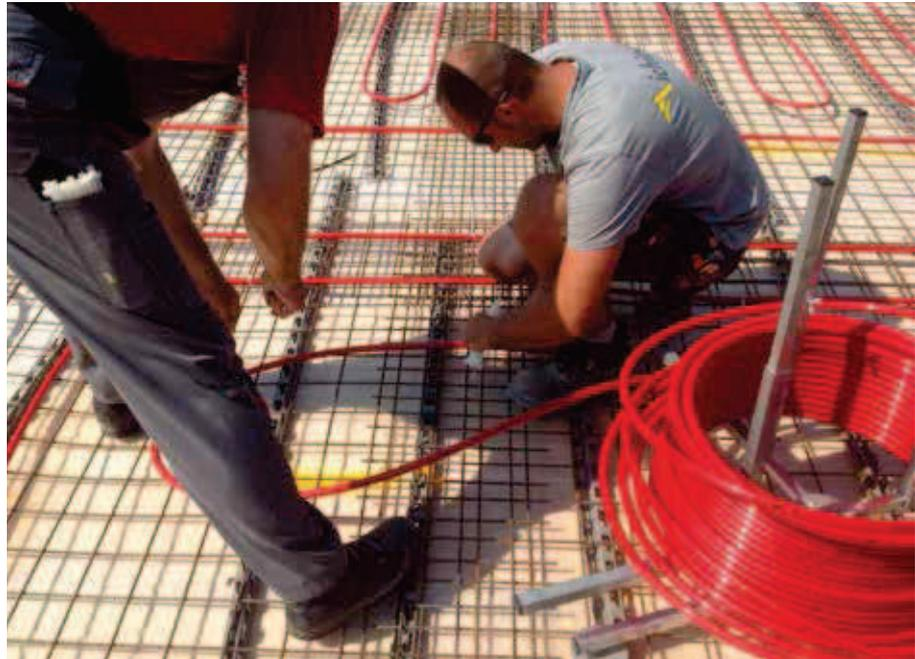
**Abb. 3** | Der Einbau von Heiz- und Kühlregistern in die Decke ist rasch, unkompliziert und damit kostengünstig möglich. © Aichinger Hoch- u. Tiefbau GmbH
