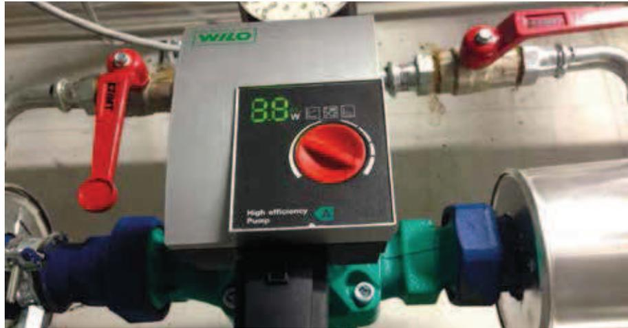
**Abb. 27** | Rohrdurchmesser und Rohrlänge und damit der Strömungswiderstand sind Kriterien zur Dimensionierung der Umwälzpumpe. © FIN – Future Is Now, Kuster Energielösungen GmbH
