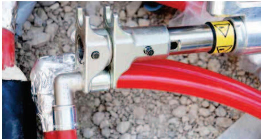
**Abb. 42** | Bei Stückelungen der Rohrleitungen wird mit einer Presse eine Hülse auf die Kupplung aufgeschoben und nachträglich geschützt. © Rehau
