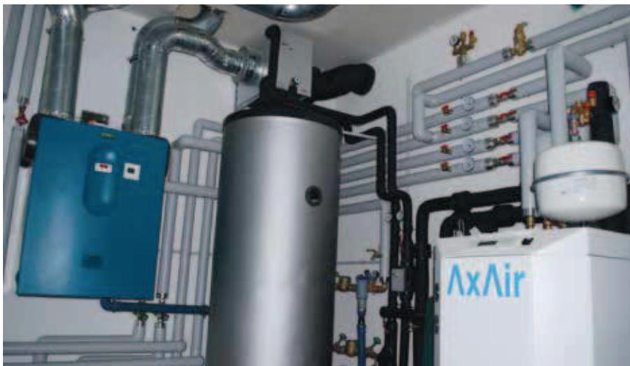
**Abb. 24** | Die Energiezentrale mit Wärmepumpe, Warmwasserspeicher, Umwälzpumpe und Verteilerleitungen etc. ist übersichtlich auf kleinstem Raum zusammengestellt.
