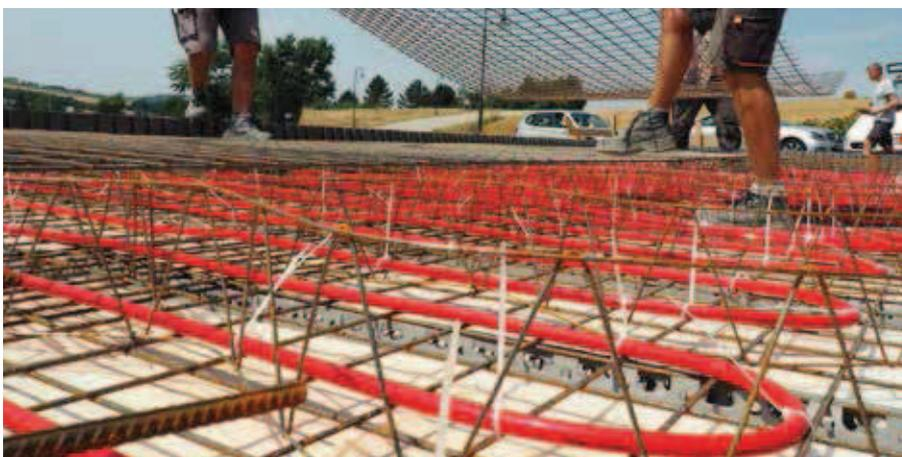
**Abb. 17** | Verlegte Heizkreise in der Decke eines Einfamilienhauses in Niederösterreich.
