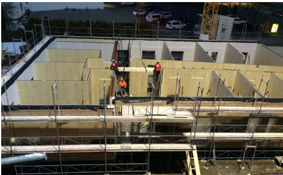
mineroom Leoben Studierendenheim tragende Struktur Erdgeschoß Montage Unterzüge
