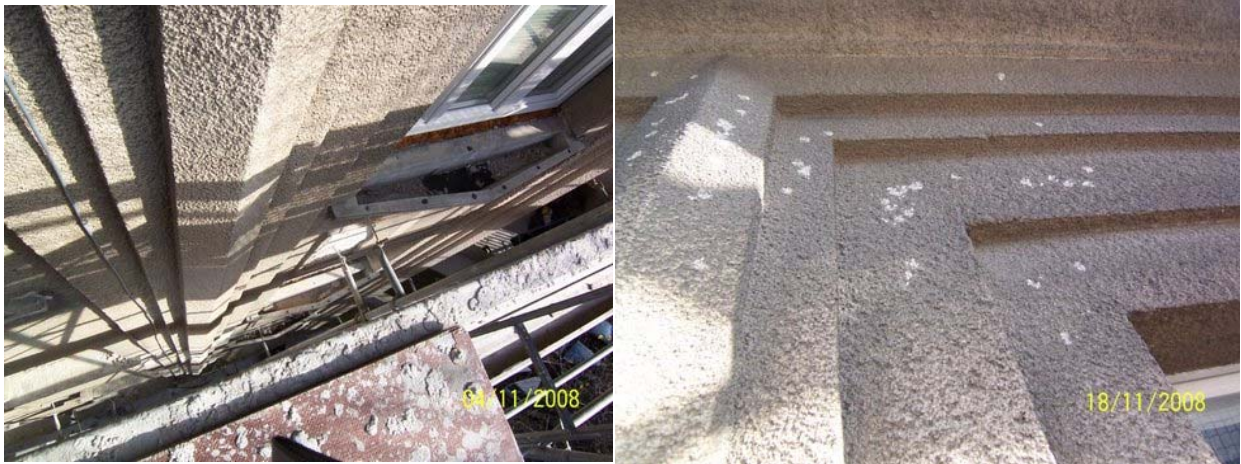
Abbildung 18: Bestandsfassade, Malfattigasse 39 (Quelle: Hofer GesmbH)
