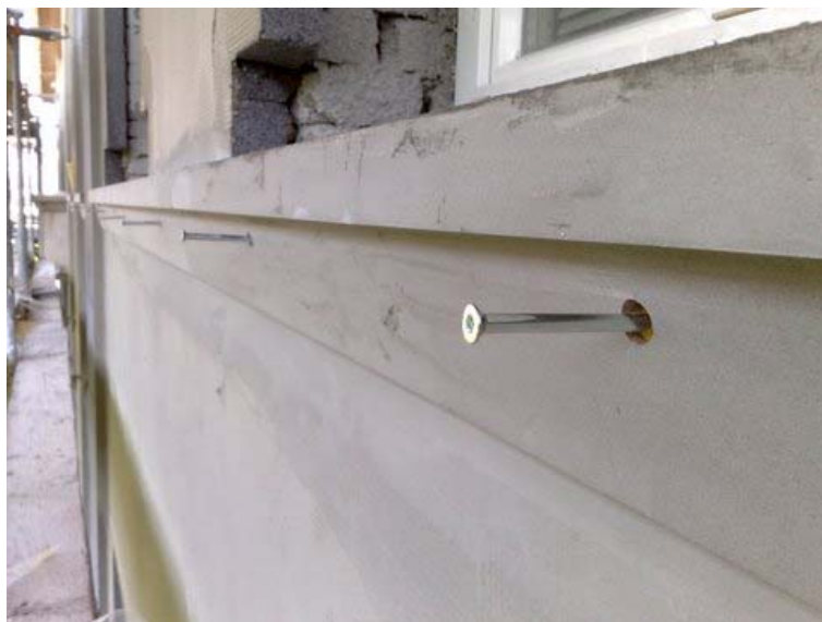
Abbildung 23: Montage Fensterbank-Profile, Malfattigasse 39 (Quelle: Hofer GesmbH)
