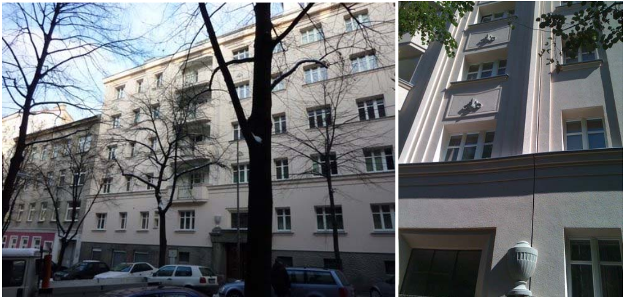
Abbildung 15: Malfattigasse 39, sanierte Fassade (Quelle: Hofer GesmbH)
