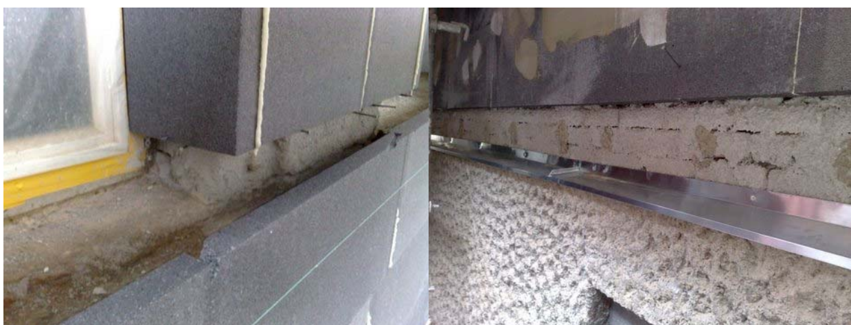
Abbildung 21: Spritzwasserbereiche und Fensterbänke freigelassen, Bleche montiert, Malfattigasse 39 (Quelle: Hofer GesmbH)
