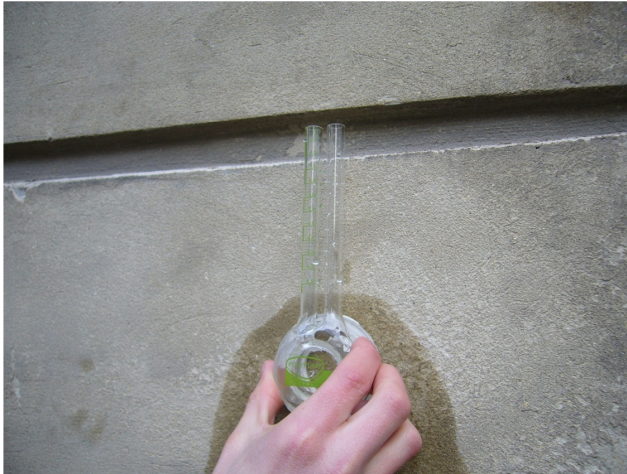
Abbildung 31: Messstelle 1 – Südfassade, EG, Bestandsputz
