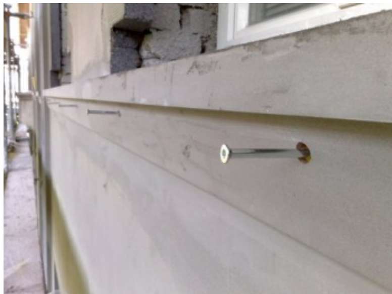
Abbildung 26: Anbringung des Fensterbankprofils, Malfattgasse 39 (Quelle: Hofer GesmbH)
