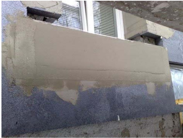
Abbildung 22: Bereiche unter den Fensterbänken mit Unterputz und Textilglasgitter vorbereitet, Malfattigasse 39 (Quelle: Hofer GesmbH)
