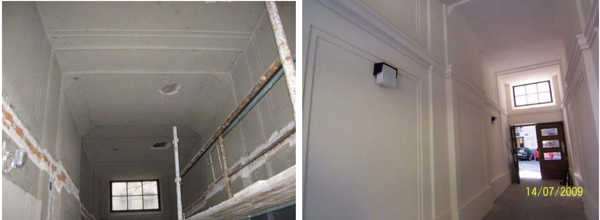
Abbildung 16: Malfattigasse 39, Durchgang zum Hof – vorher und nachher (Quelle: Hofer GesmbH)
