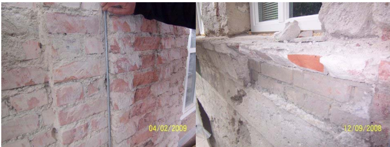
Abbildung 19: Außenputz abgeschlagen, Mauerwerk und Gesimse freigelegt, Malfattigasse 39 (Quelle: Hofer GesmbH)
