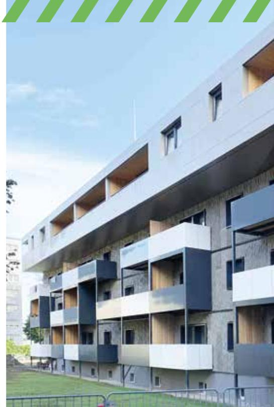
„Smart Skin - Salzburger Multifunktionsfassade“ ist ein neuartiges Fassadensystem, das eine Neukombination weitestgehend bestehender Technologien wie Bauteilaktivierung und Schallabsorber beinhaltet.
