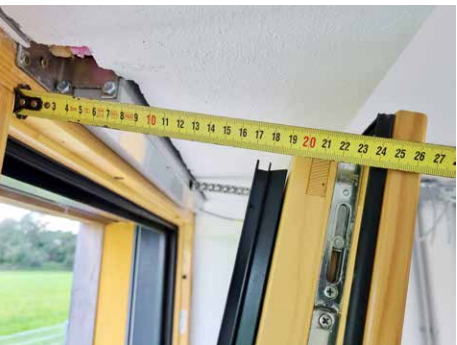
Öffnungsweiten gemessen an der Hauptschließkante; Foto: Projektteam
