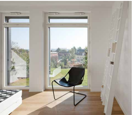
Einseitige Fensterlüftung mittels Oberlichten Foto: Adam Mørk
