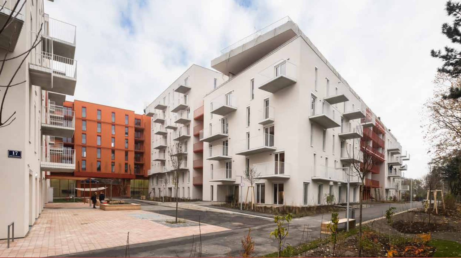
Foto: Daniel Hawelka; Wohnbau Wientalterrassen mit unabhängiger und nachhaltiger Energieversorgung, Käthe-Dorsch-Gasse, 1140 Wien
